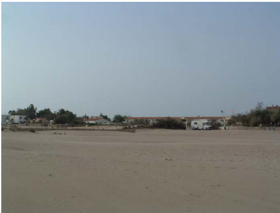
Fotografia 2: Panoràmica de la zona de Riumar des de la platja Les edificacions es troben molt properes a la platja.
